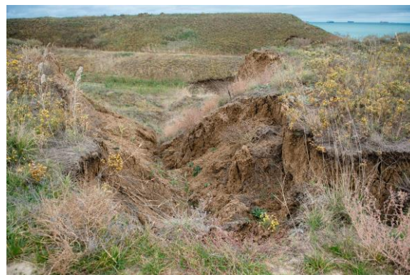
Рис. 17. Просадочность грунтов. Дата съемки 09.11.2021
